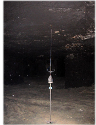
Surveillance de la convergence toit-sol
