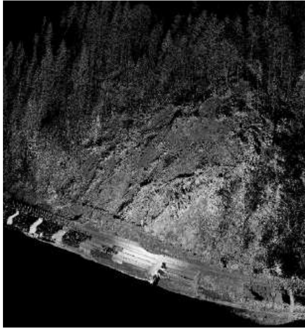
Figure 16 – Scan d'un glissement de terrain lent en Autriche [20]. Au premier plan, un cours d'eau longeant des installations industrielles ainsi qu'une route. Un glissement de terrain (zone déboisée) surplombe ces infrastructures.
